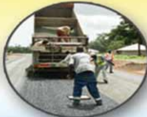
Aménagement de chaussées
